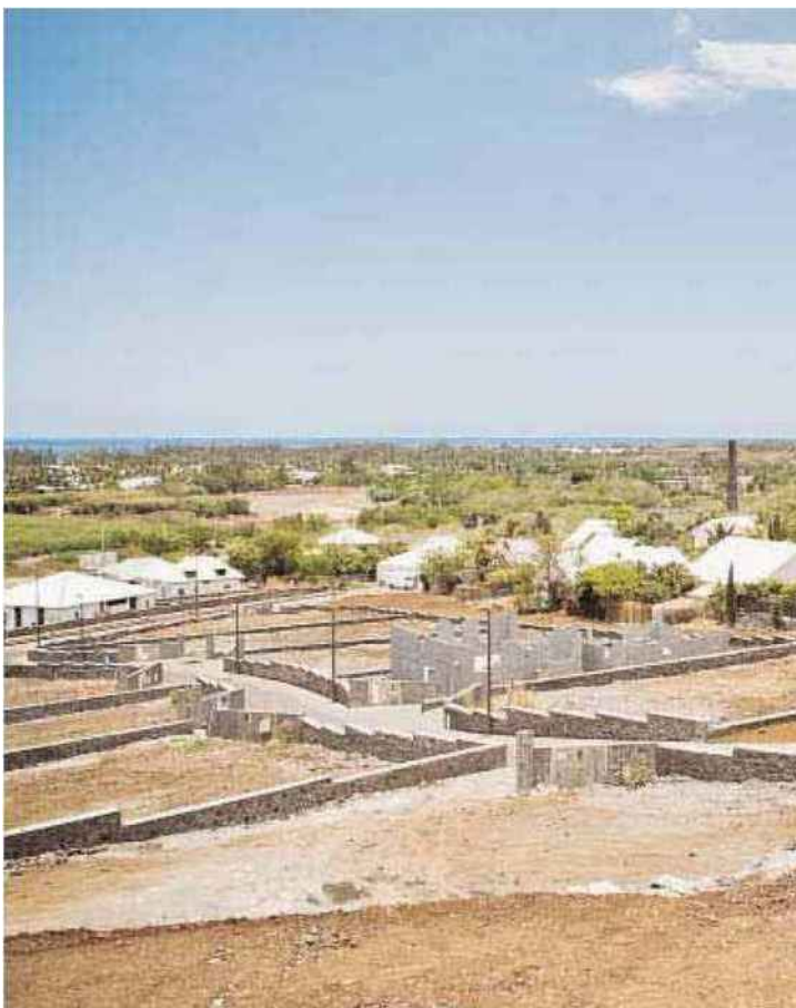
Un chantier immobilier sur la côte est de l'île de La Réunion. M. FACHE/ COLLECTIF ITEM
